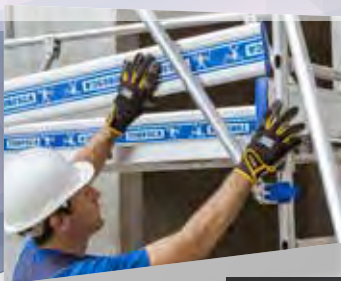
Montage des plinthes sans vis ni outil.
