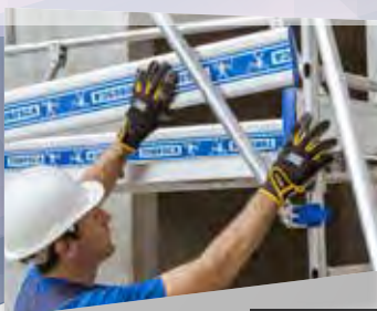
Montage des plinthes sans vis ni outil.
