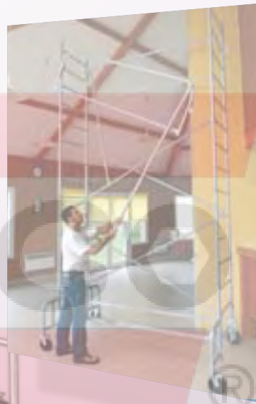
Montage en sécurité : Garde-corps et plateau par une personne
